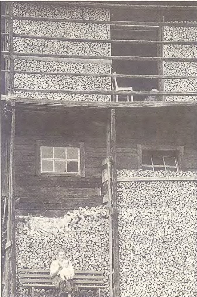
Viel „Holz vor der Hütte“. Auf die Erhaltung bäuerlicher Traditionen und der Bausubstanz wird großer Wert gelegt.
